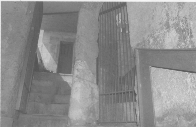
Accés antic i modern a la coberta de la nau central. Al fons s'observa la porta que condueix a la Sala de les Campanes
