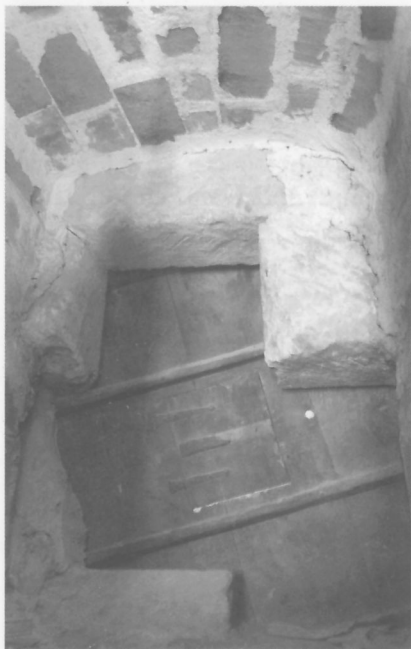
Càvitat practicada al mur del creuer i la Sala dels Monjos per situar-hi la maquinària del primer rellotge de què tenim constància (s. XV)
