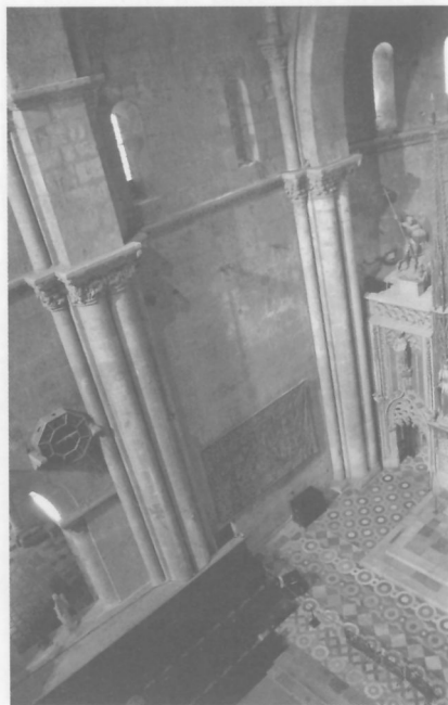
Detall del presbiteri on s'observa el canvi d'alçada de la volta (marcat per la doble cornisa) i les finestres romàniques
