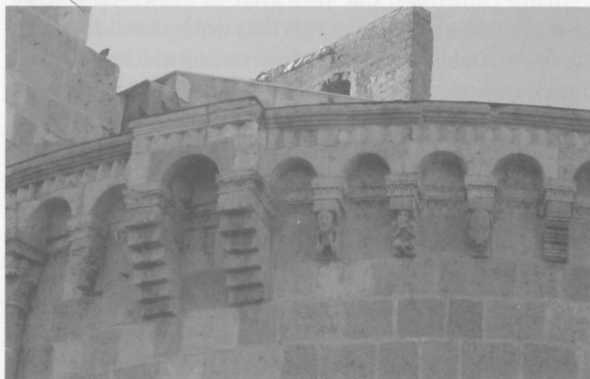
Detall de la cornisa exterior de l'absis de la seu on s'observa un dels matacans (s. XII)
