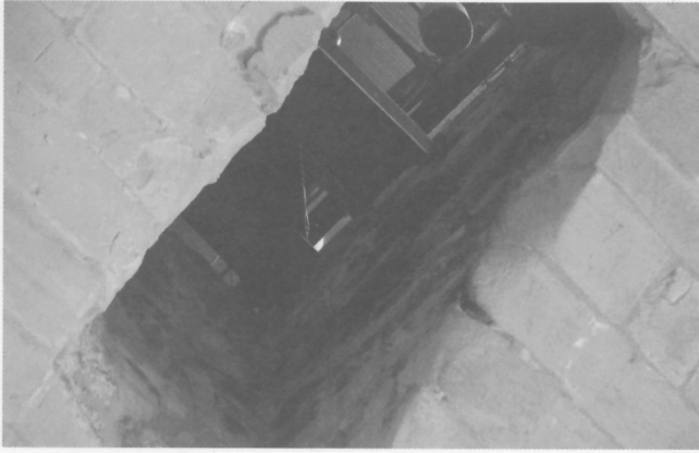
Detall de la maquinària del rellotge (situat al pis superior) i de les peses, que descendien per l'interior de la sala
